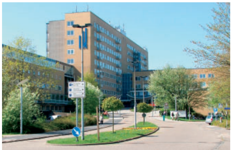
Beim Reinhard-Nieter-Krankenhaus in Wilhelmshaven konnte im Rahmen von Energiespar-Contracting die Auslegungs-Gesamtwärmeleistung von 16 auf 5 Megawatt gesenkt werden.
